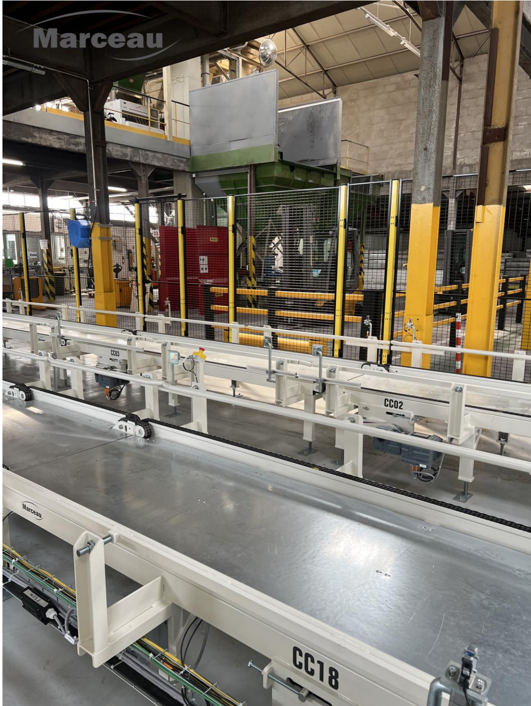
Pilotage de trémies de remplissage
